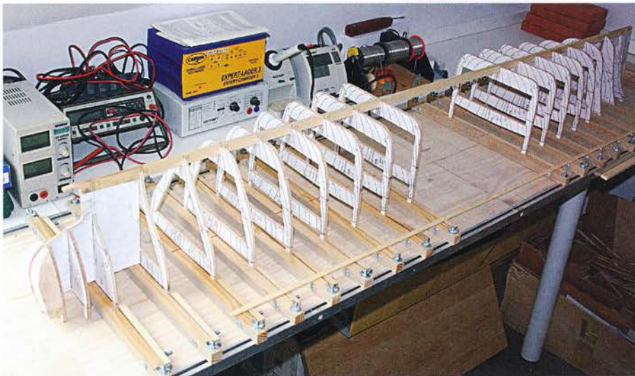
Ossature sur le chantier.
